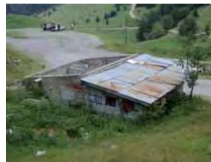
Démolition de la ruine
