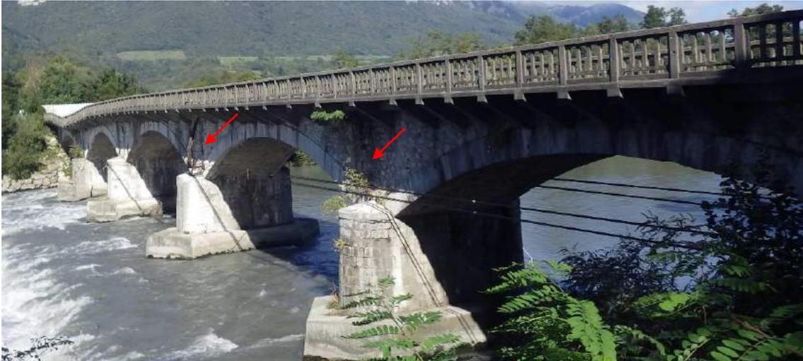
*Illustration 2 : Disjoints et fissures notés sur le Pont de la Buissière (source : Acer campestre)*
