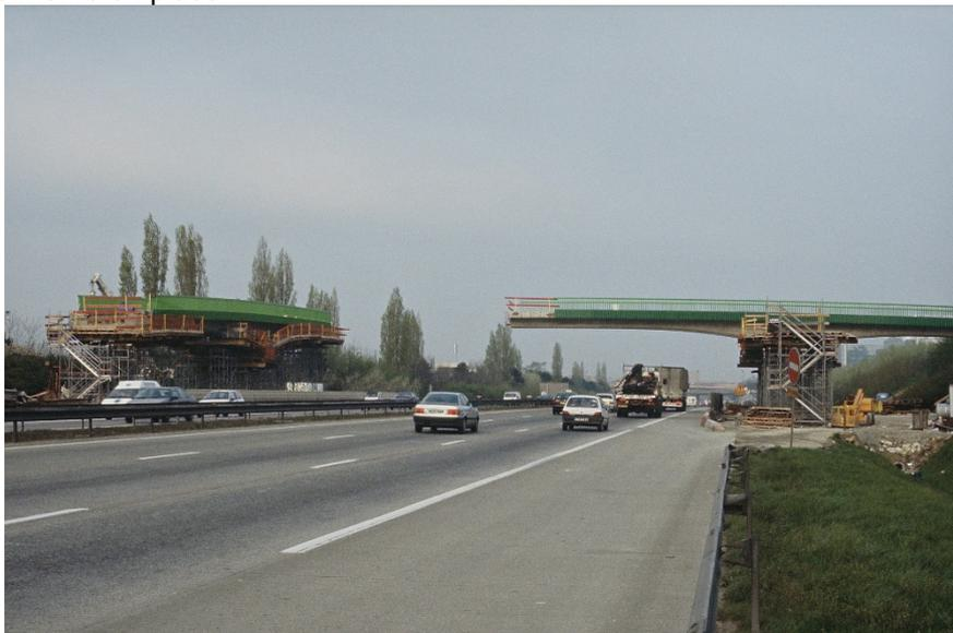
**Photo 13.** Passerelle de Marne la vallée mise en place par rotation au-dessus d'A4.
