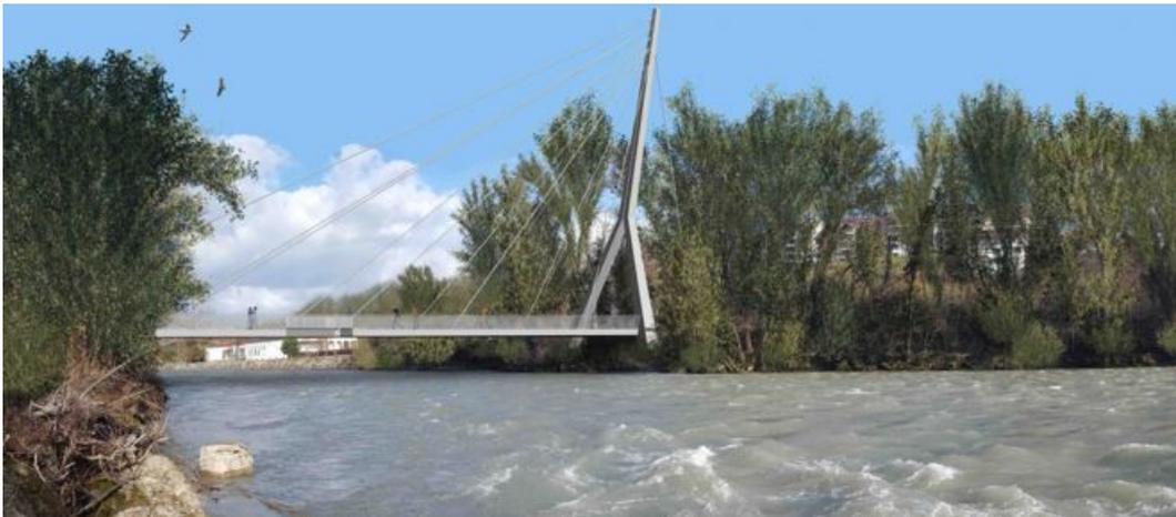
**Photo 12** : exemple de passerelle haubanée à un seul pylône : Annemasse- Etrembières
